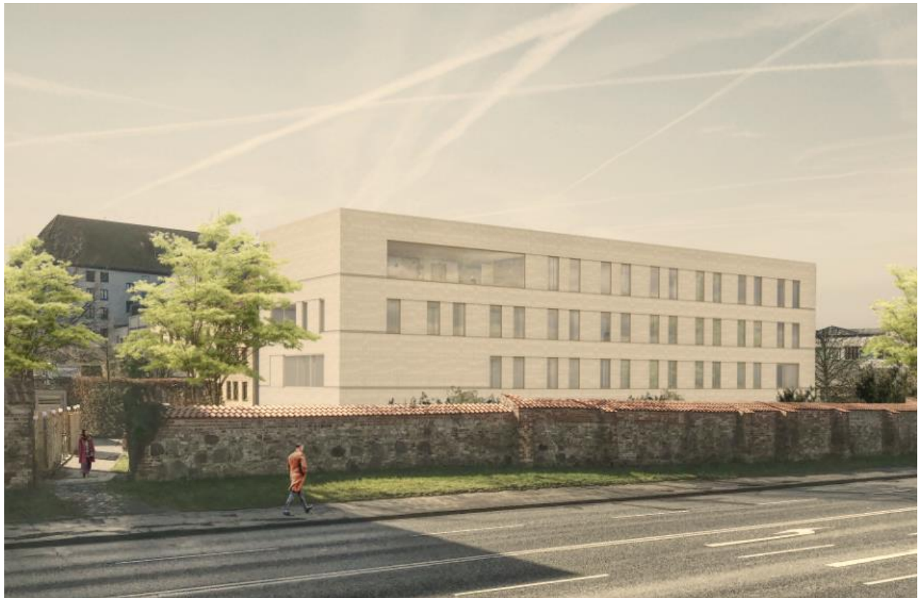
Neubau Pop- und Weltmusik einschl. Cafeteria / Mensa Visualisierung Blick von der Straße Am Strande © 2022 Knoche Architekten Partnerschaftsgesellschaft mbB, Leipzig
